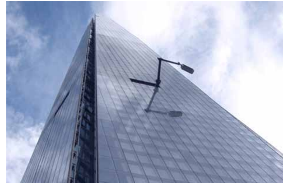
Durch Spezialtore werden im höchsten Gebäudes der EU (The Shard) Fensterwaschanlagen ausgefahren.
