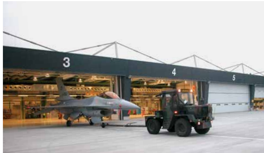
Hangar-Sicherheit: einbruchhemmende Tore und thermisch gedämmtes Sektionaltor
